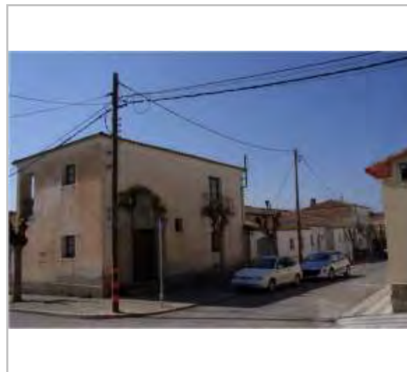
Vista del conjunt
