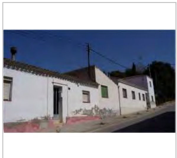
Vista del conjunt
