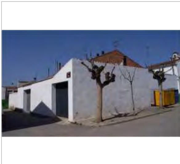
Vista del conjunt
