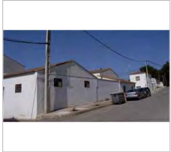
Vista del conjunt
