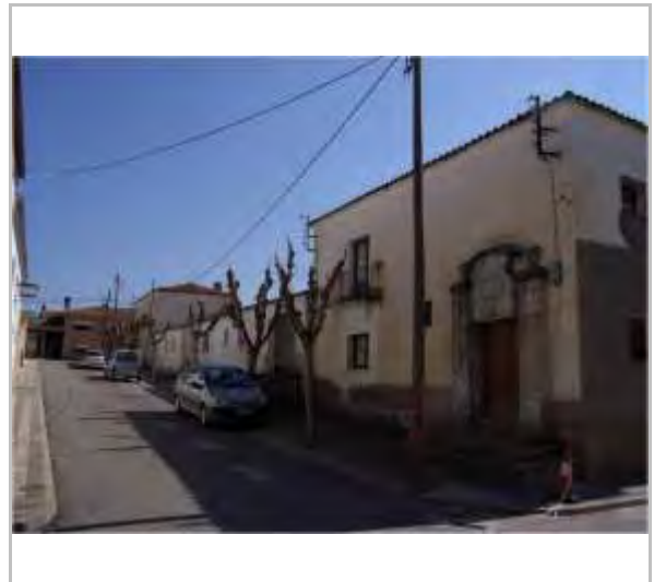
Vista del conjunt
