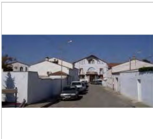
Vista del conjunt
