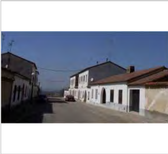
Vista del conjunt
