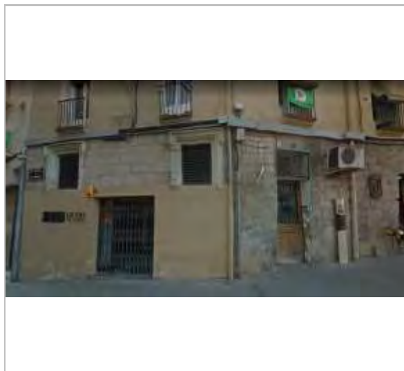
Vista de l'edifici
