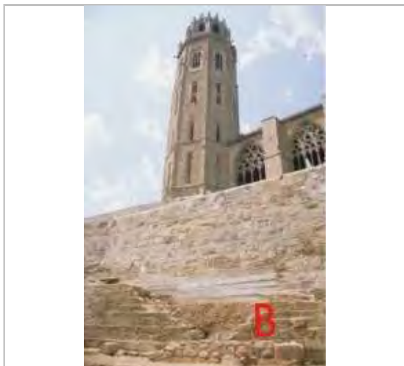
Fonamentació de la façana d'un gran edifici (B) Arxiu Arqueològic - Ajuntament de Lleida
