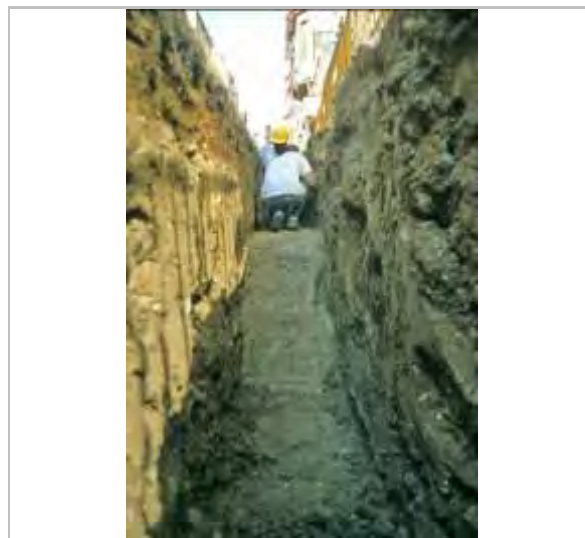
Vista del tram localitzat
