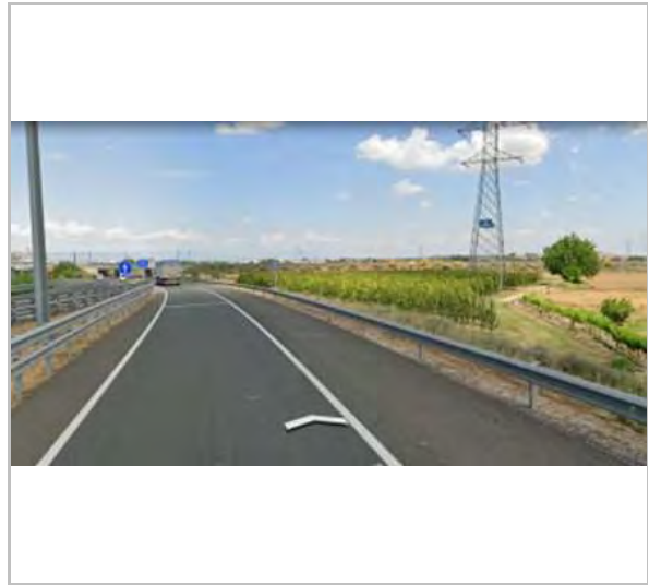
Vista general des del sud.
