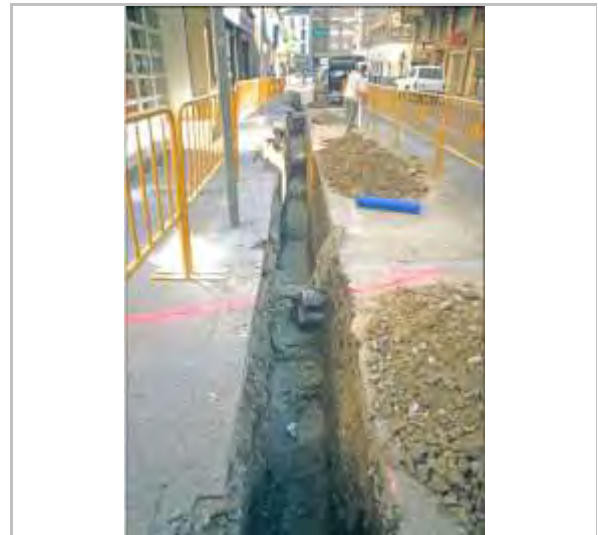
Vista del tram localitzat
