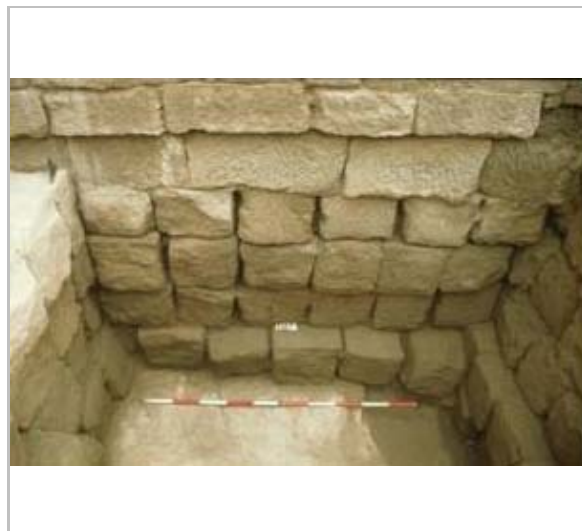
Cara interna del tancament sud-oest de la Medina
