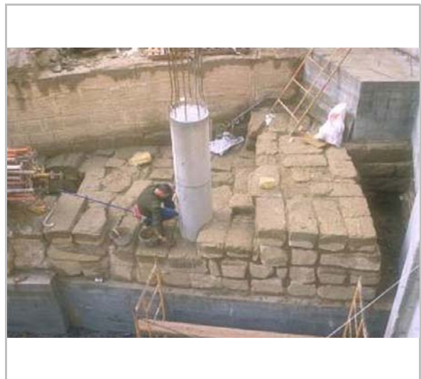
Treballs d'integració de les restes en l'edifici Arxiu Arqueològic - Ajuntament de Lleida
