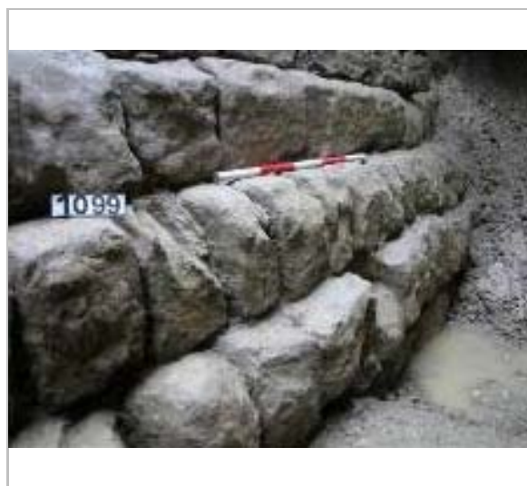
Detall de la fonamentació graonada
