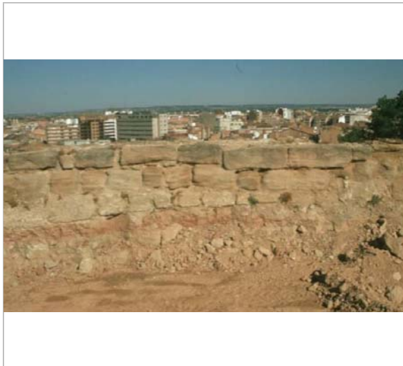
Parament interior del mur de tancament del baluard Arxiu Arqueològic - Ajuntament de Lleida
