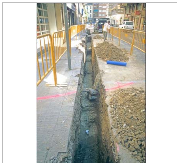
Vista del tram localitzat
