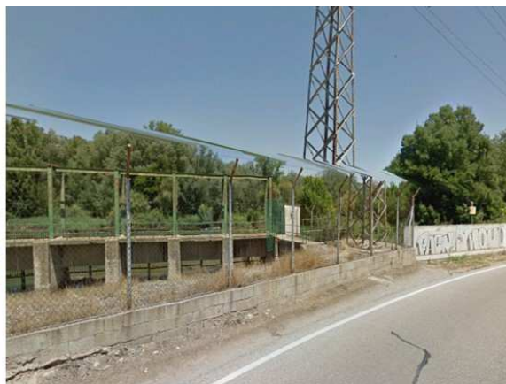
PUNT CRÍTIC ON NO HI HA CONTINUITAT ENTRE EL MUR DE DEFENSA I LA PRESA DEL CANAL DE SERÒS
