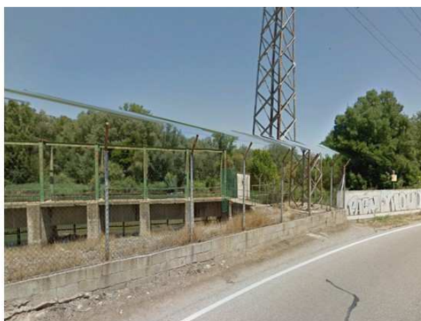
PUNT CRÍTIC ON NO HI HA CONTINUÏTAT ENTRE EL MUR DE DEFENSA I LA PRESA DEL CANAL DE SERÒS
