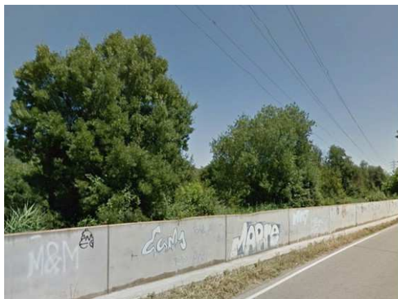
MUR EXISTENT ENTRE LA PRESA DEL CANAL DE SERÒS I LA CLAMOR DE LES CANALS
