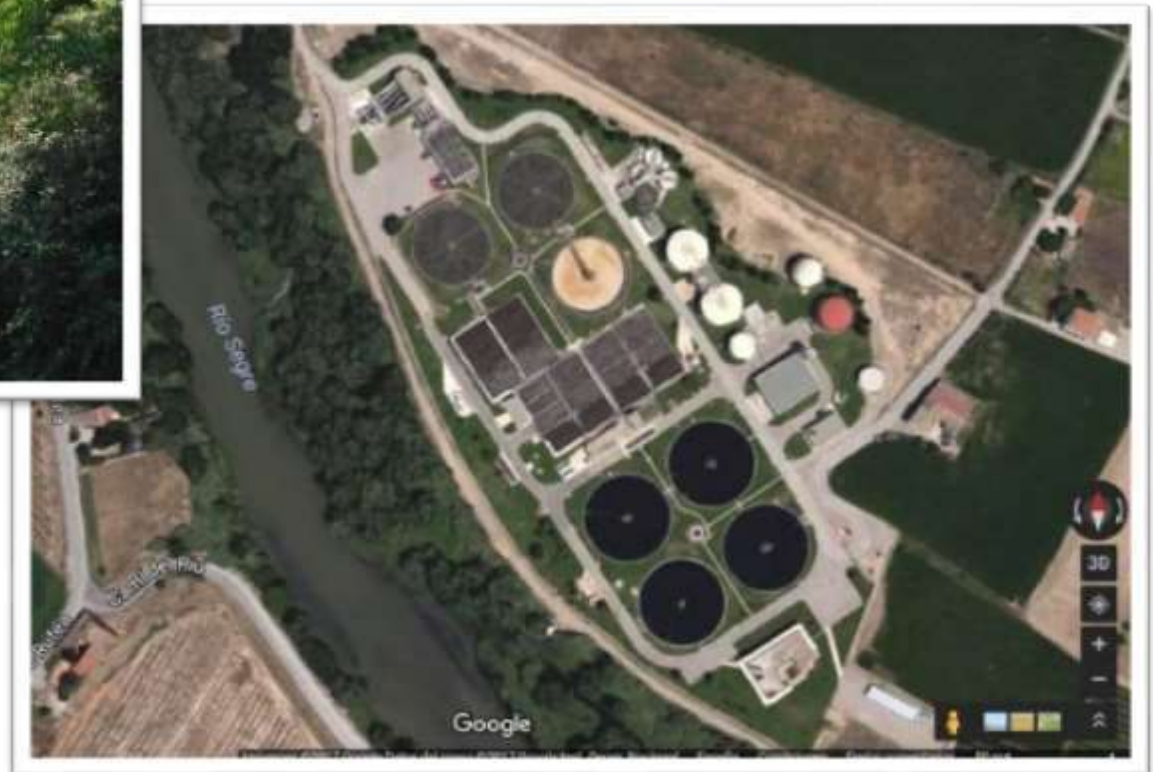
Estació Depuradora d'Aigües residuals de Lleida
