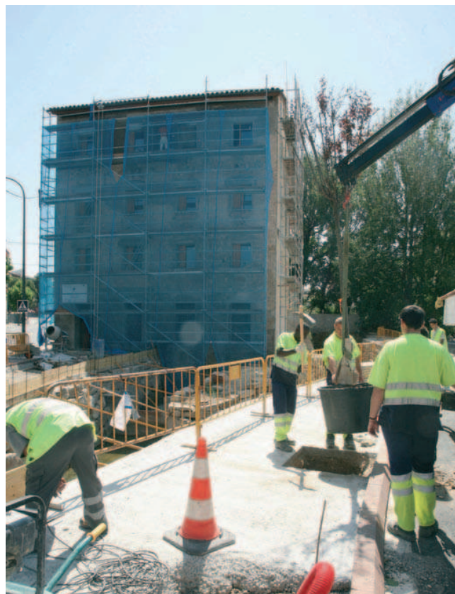
S'ha instal·lat arbrat, mobiliari urbà, fanals i una vorera a Impressor Botel.
