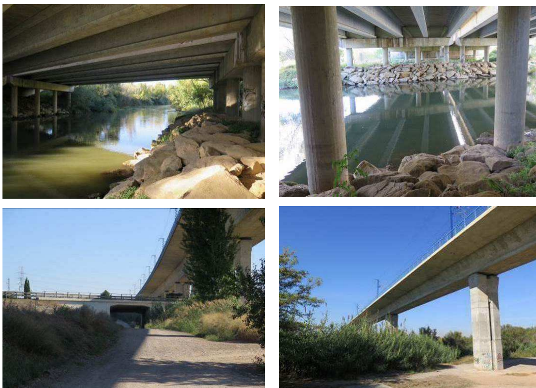
Figura 1.65. Imatges del viaducte de l'A-2 i del viaducte del tren d'alta velocitat.
