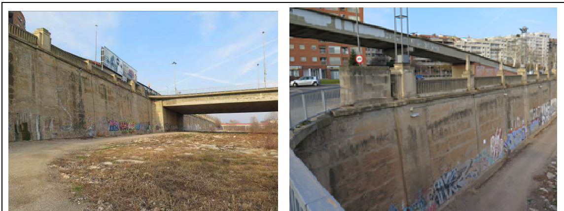
Estat actual del mur a l'entorn del pont Nou, possible localització de la nova rampa a construir.
