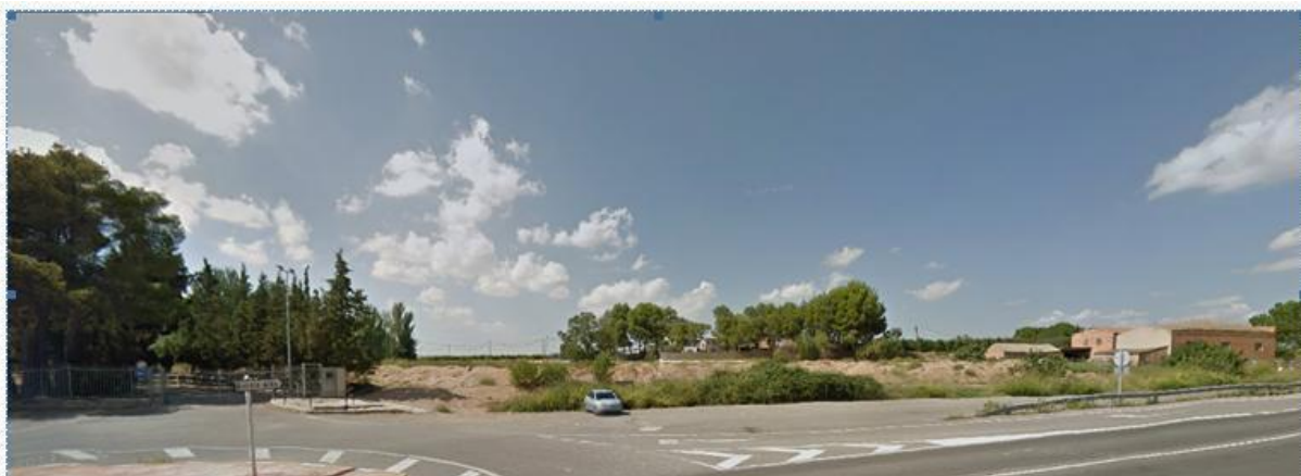
Figura 11 Vista abans de la intervenció, d'est cap a oest
